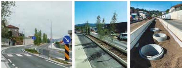
Dall'alto, tetti verdi e Sistemi di Drenaggio Urbano Sostenibile.
