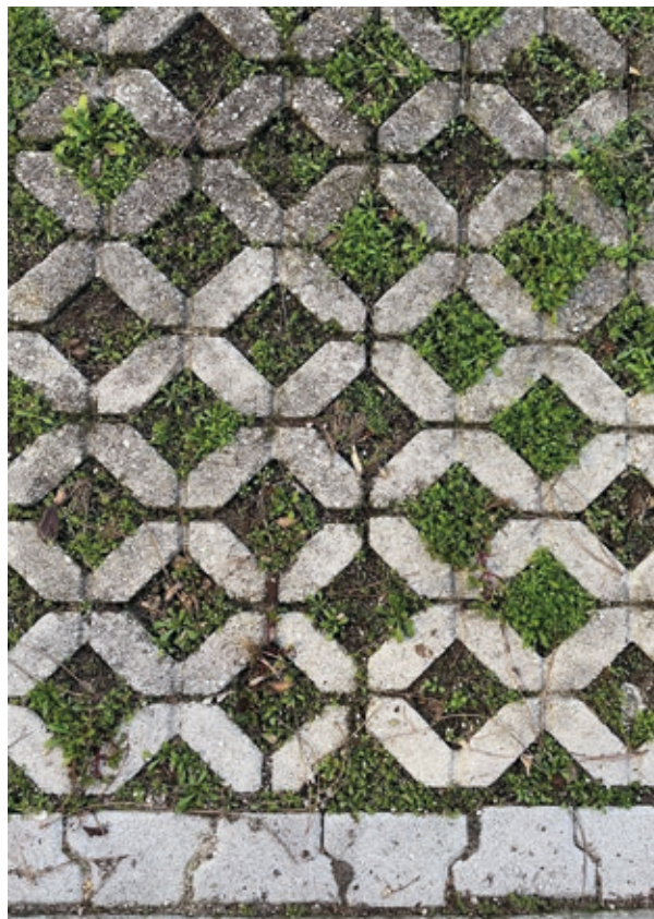
Esempio di pavimentazione drenante in grigliato erboso.
