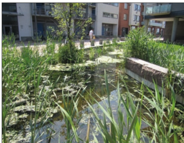
Rain garden a Vastra Hamnen (Malmö, Svezia).
