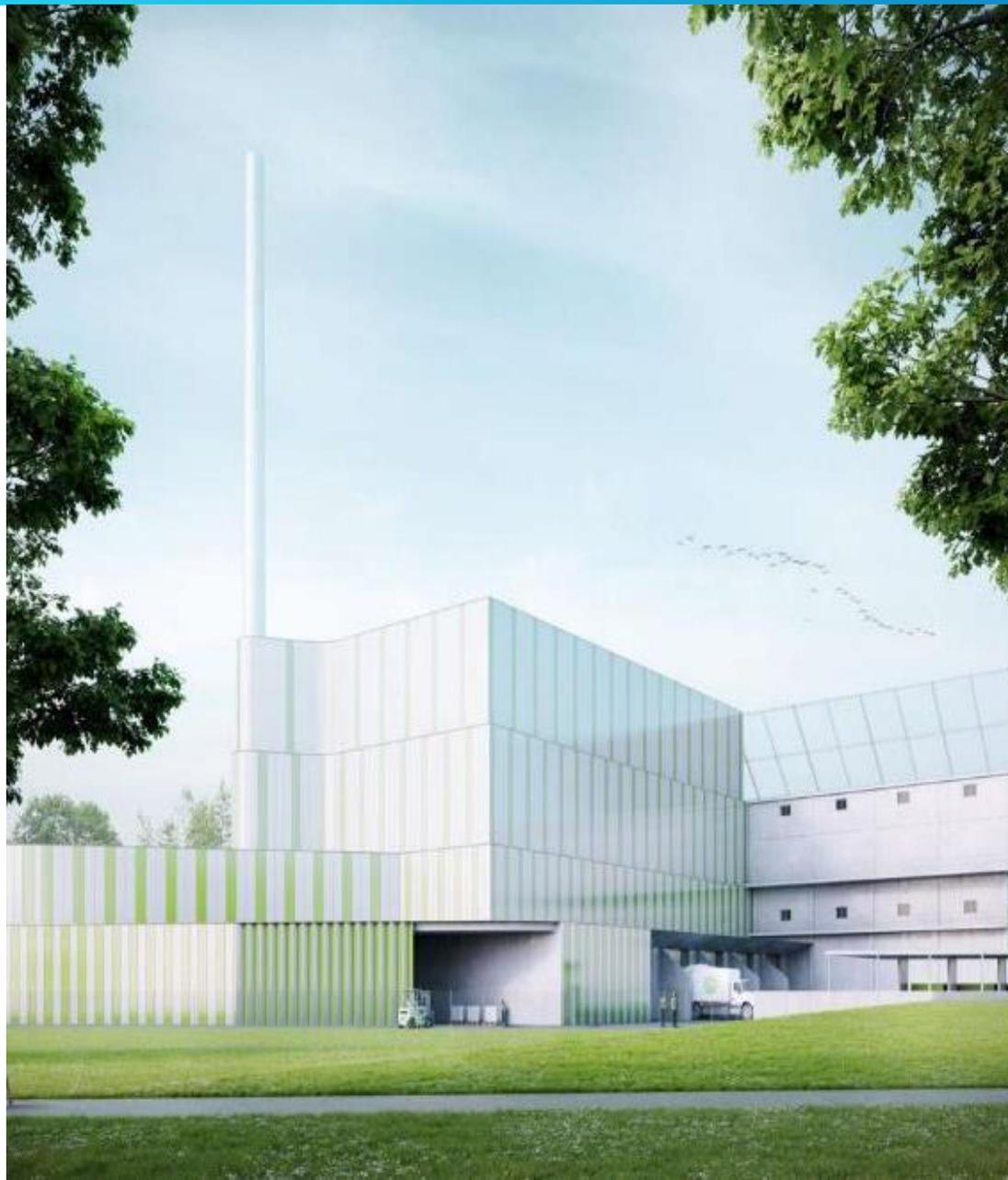
La linea FANGHI valorizzerà **65.000 tonnellate/anno di fanghi umidi** pari a 14.100 tonnellate/anno di fanghi prodotti dai depuratori del Gruppo CAP, generando: 11.120 MWh/anno di calore per il teleriscaldamento e fosforo come fertilizzante.
