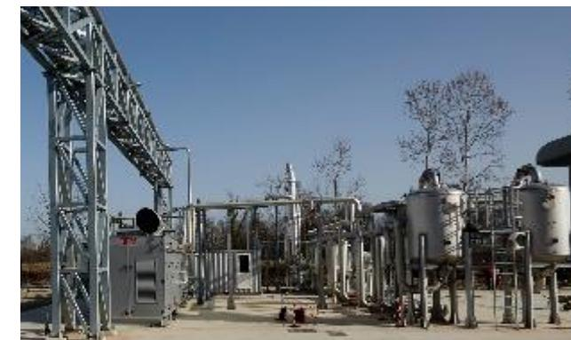
Il sistema di **upgrading** prevede **torre di lavaggio, carboni attivi e membrane**
