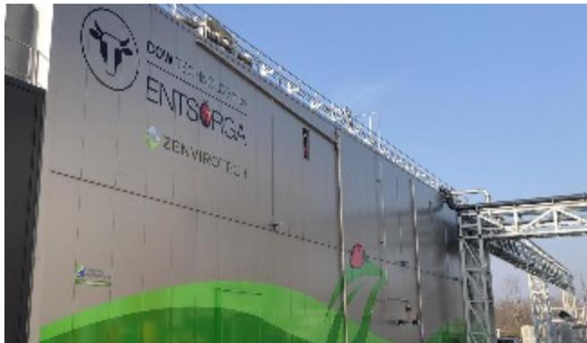
Il digestore è un **Semi Dry Plug Flow** con agitatore assiale e riscaldamento ad alta efficienza con iniezioni di vapore.
