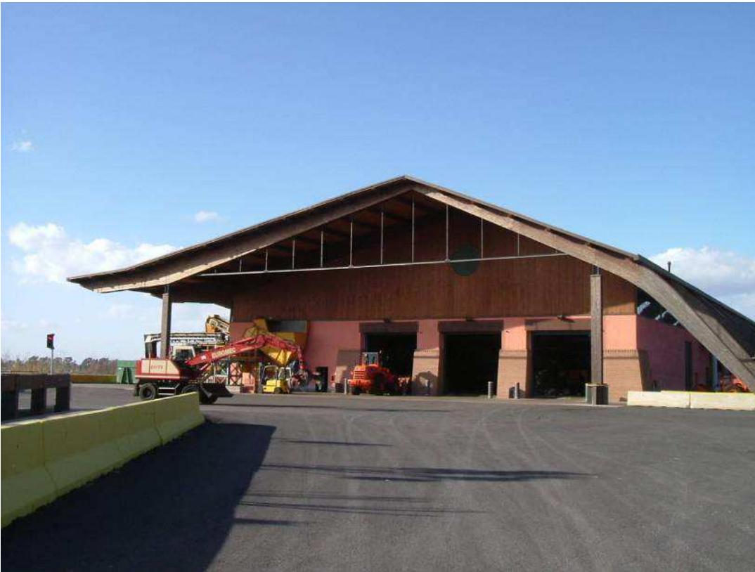
Fig.1 - Veduta dell'ingresso principale dell'impianto di compostaggio.
