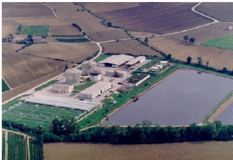
Impianto di Marsciano (PG)
