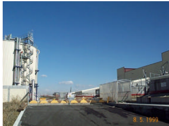
Impianto centralizzato di Camposampiero (PD): sulla destra il capannone che ospita la linea di pretrattamento della FORSU
